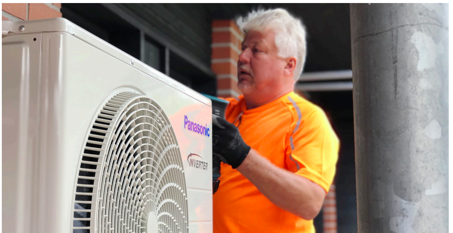
Ilmalämpöpumpun asennus ei vaadi erikoisratkaisuja talon rakenteisiin, mutta työssä on käytettävä ammattipätevyden omaavaa asentajaa, muistuttaa Ismo Tuominen .
