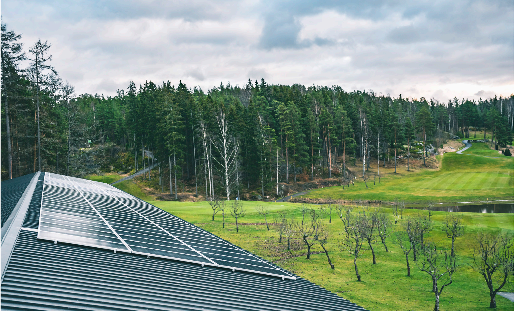
Aurinkopaneelille löytyi hyvä paikka Aurinko Golfin ison huoltorakennuksen katolta. Paneeleita asennettiin yhteensä 141 kappaletta. Kuva: Martin Vallenius
