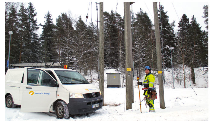
Verkkoasentaja Janne Vähä-Mäkilä purkaa vanhaa 20 kilovoltin erotinasemaa Soinistentiellä.
