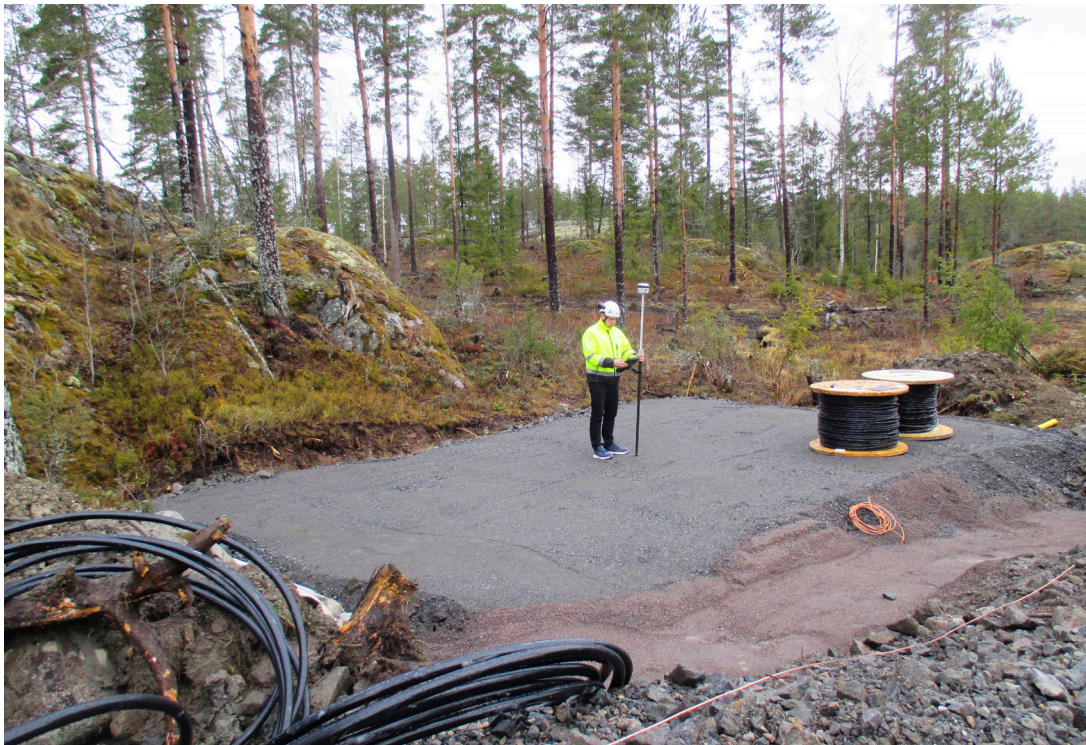
Perusinfran rakentaminen on käynnissä asuntomessualueella.
