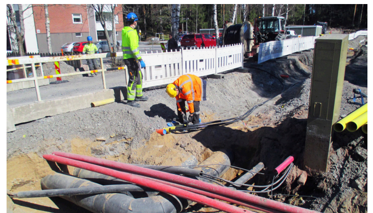
Maakaapelointityöt edistyvät Aurinkotien ja Nuhjalantien risteyksessä.
