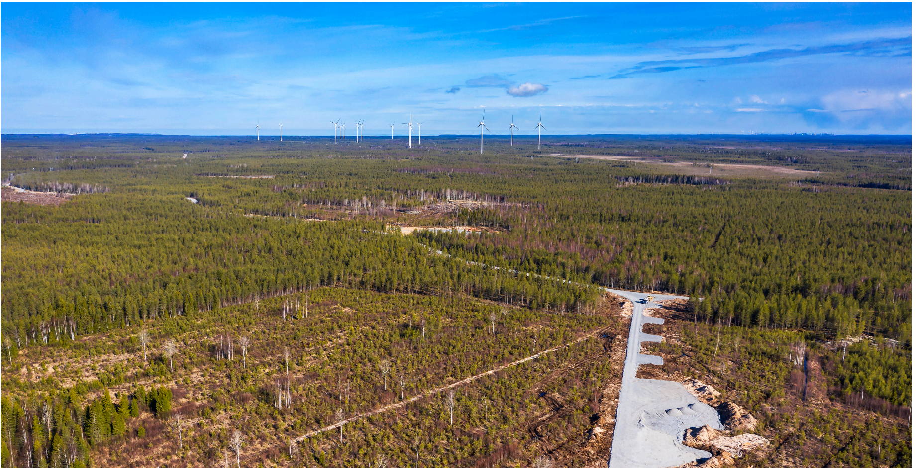
Parhalahden alueelle rakennetaan kymmenen tuulivoimalaa ja Hankilan alueelle kahdeksan tuulivoimalaa. Kuva: Puhuri Oy
