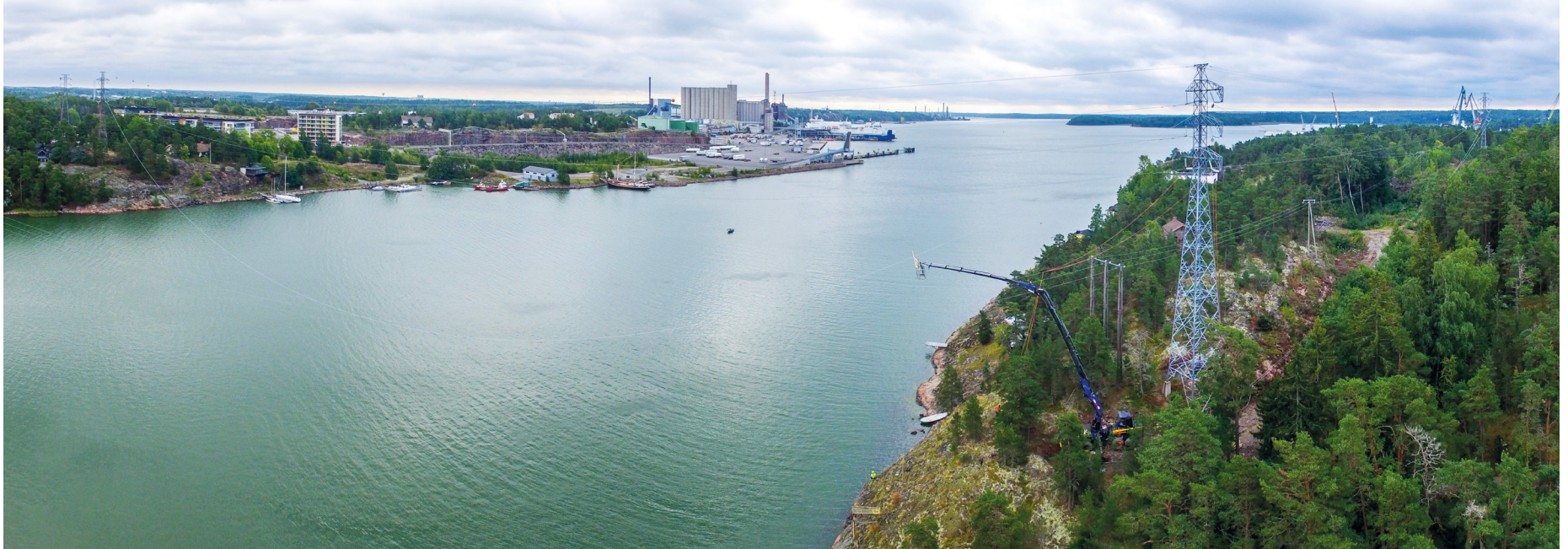
Uusi 110 kilovoltin alueverkko rakennettiin ilmajohtona Karvetin sähköasemalta Naantalsalmen yli Luonnonmaalla olevalle Kukolan sähköasemalle. Johto-osan pituus on 3,4 kilometriä.
